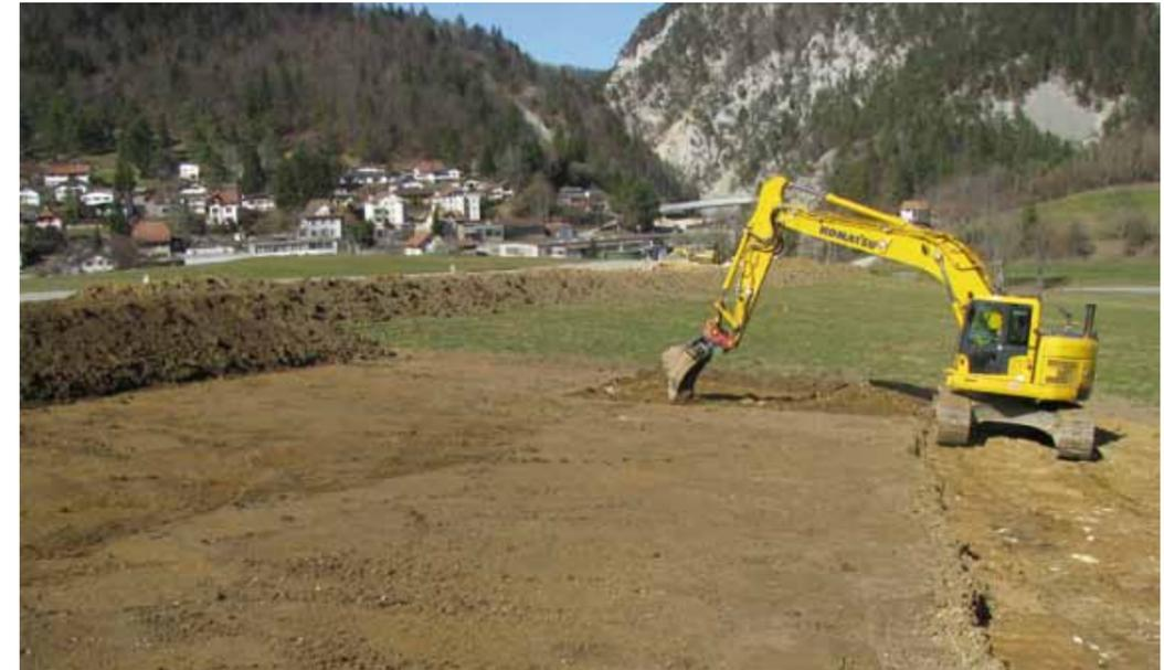
Lot A / Zone de stockage pour matériaux de terrassements et Galerie de Malleray: Au printemps 2012, une zone d'environ 15'000 m<sup>2</sup>, située au sud de la future Galerie de Malleray a été restituée (zone de drainage). Niveau décapages, une zone pour permettre le stockage provisoire des matériaux de terrassement en provenance de la Galerie de Malleray, d'une surface d'environ 28'000 m<sup>2</sup> a été décapée dans le courant du mois de mai dans de bonnes conditions pédoclimatiques.
