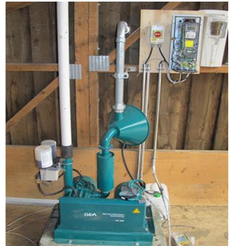
Figure 21: Variateur de fréquence sur le moteur de la pompe à vide
