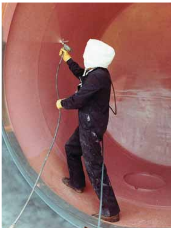
Fig. 6: les résines époxy sont une cause fréquente d'allergies cutanées. Lors de l'utilisation sur de grandes surfaces et surtout lors d'applications au pistolet, la présence de vapeurs et d'aérosols dans l'air ambiant peut provoquer des eczémas. Il est donc nécessaire de protéger la peau dans sa totalité.
