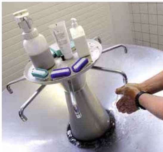
Fig. 17: poste de lavage dans une entreprise de l'industrie de la métallurgie proposant différents produits de nettoyage en fonction du niveau de saleté de la peau.
