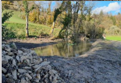
Figure 2 : Mare du Tchaimp Meutie remise en état. Les travaux ont consisté à retirer la vase accumulée et à débroussailler partiellement les berges.
